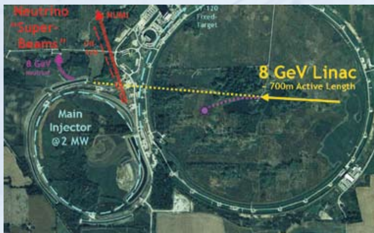
Рис. 6. В настоящее время ведется строительство линейного сверхпроводящего ускорителя протонов на 8 ГэВ (Fermilab, США)
